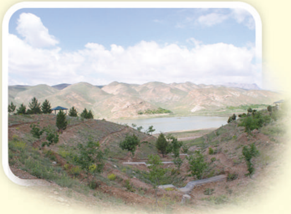
تصویری از عملیات آبخیزداری
